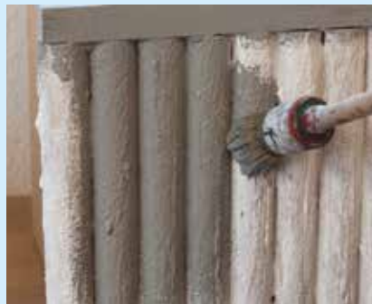
Fehlt nur noch der Anstrich in Beton grau mit einem groben Pinsel.
