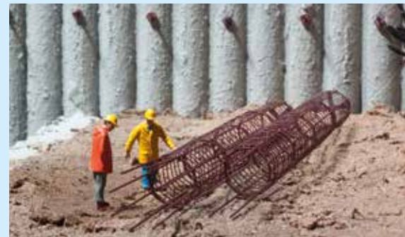
Bewehrungskörbe im Eigenbau aus Draht und Kunststoffringen.
