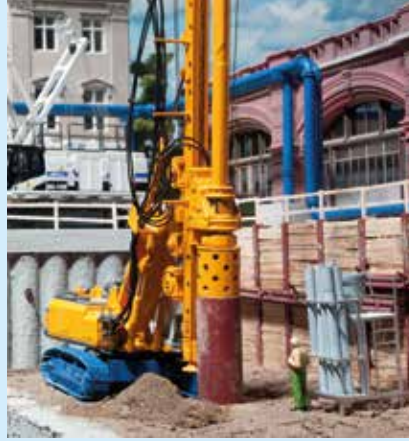
Verrohrte Bohrung mit Bauer BG24, rechts Betonierrohre mit Trichter.
