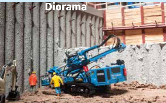
Ankerbohrungen mit einem Hütte HBR605 Bohrgerät von Ros.
